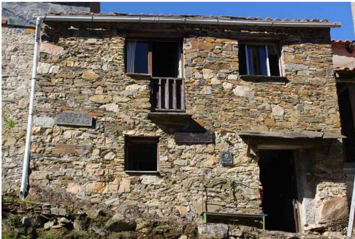
Fig. 8. Casa do Casarão onde se localiza o Centro Interpretativo dos Icnofósseis dos Penedos de Góis.
